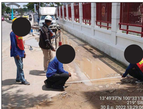
ตรวจสอบแนวท่อและระบบสาธารณูปโภคเดิม
